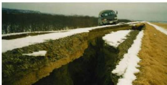
図5 釧路沖地震で地割れが起きた様子
