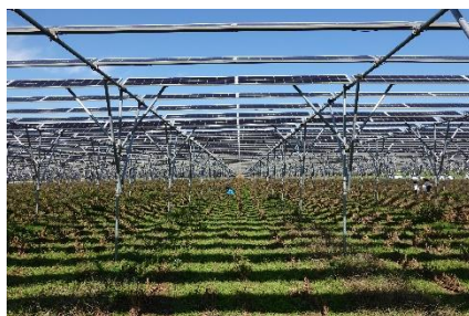
【資料70】畑の上に設置された太陽光発電パネル
