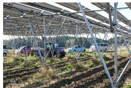
【資料71】筋交いにより台風被害も免れた
