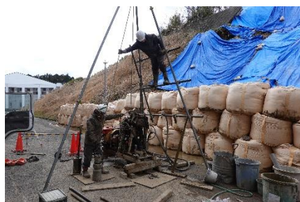
【資料 32】実際のボーリング調査の様子
