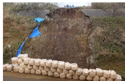
【資料25】フレコンバッグが設置
