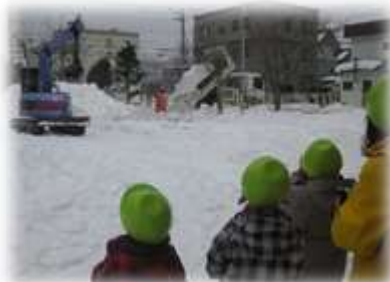
ヘルメットをかぶって作業を見守り中
