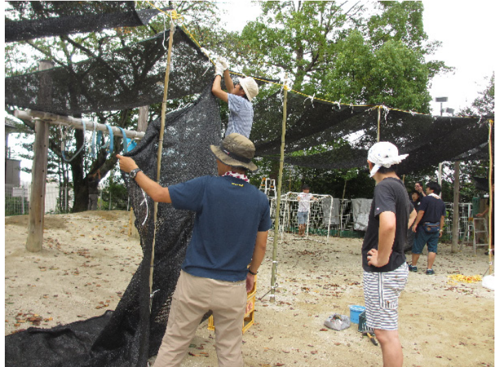
図 20 寒冷紗張りでロープワークを駆使する
