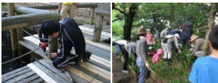
写真：H27年7月の錦の森とビオトープでの作業風景
