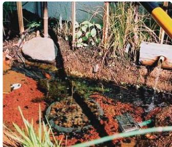
いよいよ、4月下旬、池の改修工事が始まった。ここにエサとなるカワニナとゲンジボタルの幼虫を放流する。水は、水道水を滝の原理で浄化し、さらに濾過して、循環させる。渓流のようなわけにはゆかず、「山深く、水清いところ」に近づけるのは、並大抵のことではない。夏の日差しを避けるためにヨシズを、そして、水温の上がるような時には、冷凍庫の氷を、とスタッフはいろいろ智恵を出し合い準備を始めた。
