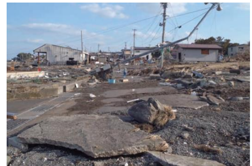
写真②大蛇地区の被害。アスファルトがはがれ、防災無線も倒れている
